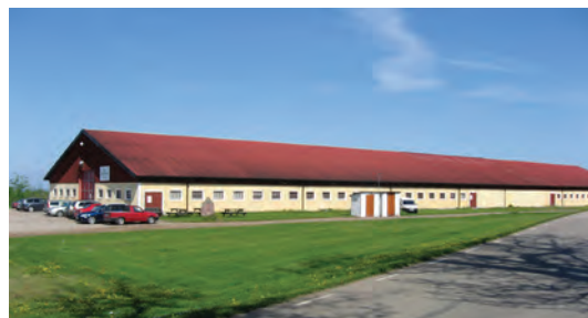
Fabriksbyggnad vid Blomberg.
